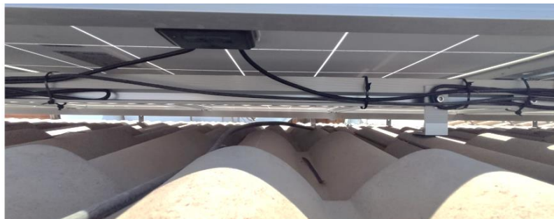
Figura 11-3 Correcta sujeción del cableado.
