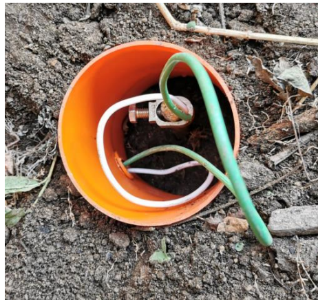
Figura 13-1 Conductor de tierra hasta el electrodo.
