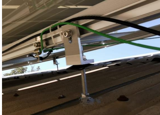
Figura 10-1 Perno de anclaje correspondiente a techumbre de zinc con orificio sellado
