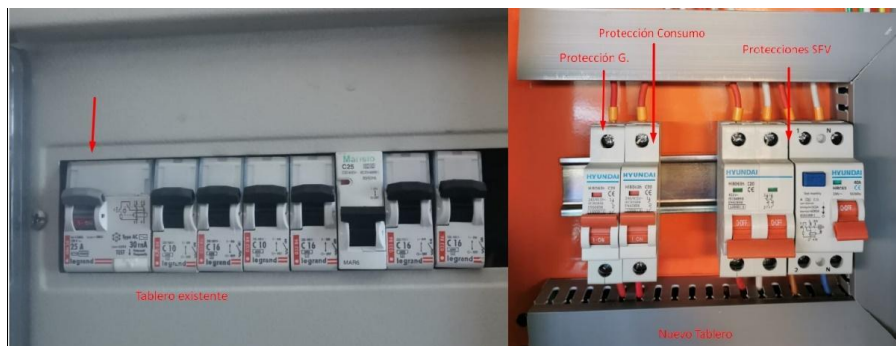
Figura 11-7 Protecciones tablero existente (izquierda) y protecciones nuevo tablero general.
