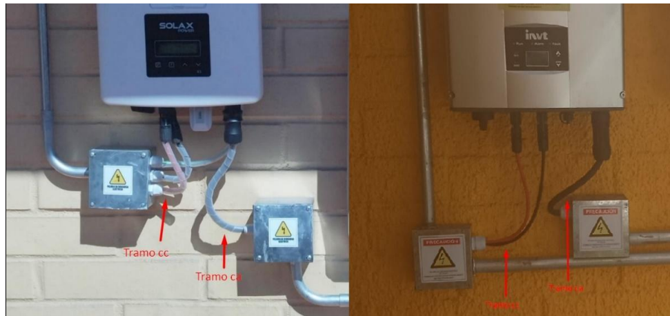
Figura 11-4 Tramo entrada CC y salida CA del inversor.
