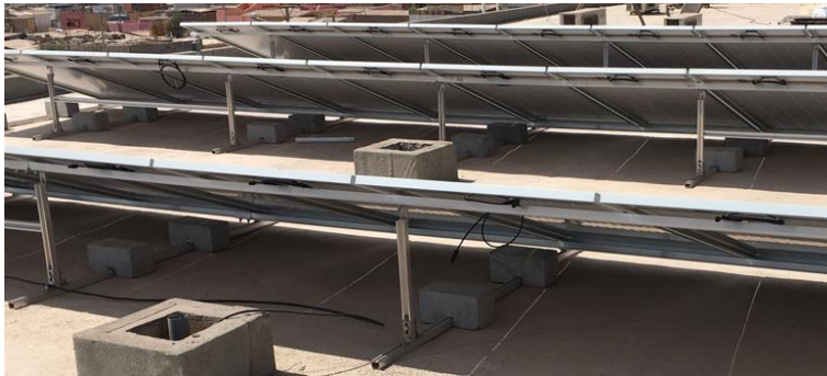
Figura 10-3 Lastre utilizado para instalaciones fotovoltaicas en losa de hormigón.
