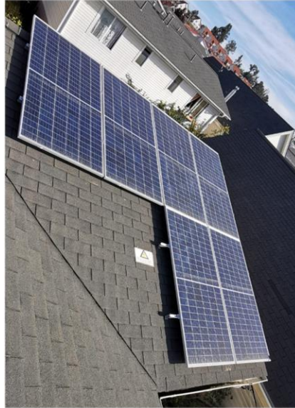
Figura 7-1 Distribución en L de proyecto de 2 kWp.
