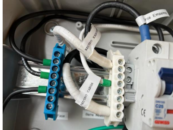
Figura 11-9 Rotulado de conectores.
