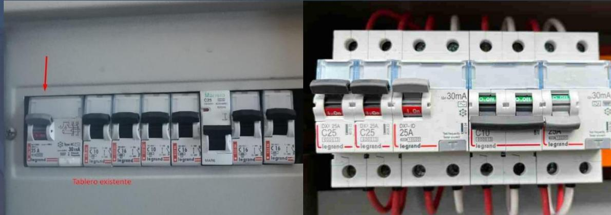
Protecciones tablero existente (izquierda) y nuevo tablero general (derecha)
